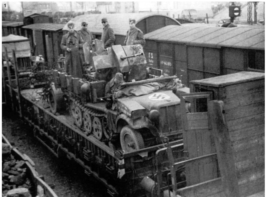
Dieser Konvoi ist gerade in Galizien, in der Region Lemberg (Lviv), angekommen. Man sieht einen Sd.Kfz 10/4, also eine 2-cm-Flak 38, die auf einem 1-Tonnen-Halbkettenfahrzeug montiert ist.
